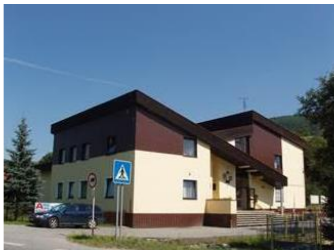
Obrázok č. 7 Viacúčelová budova obecného úradu a kultúrneho domu
